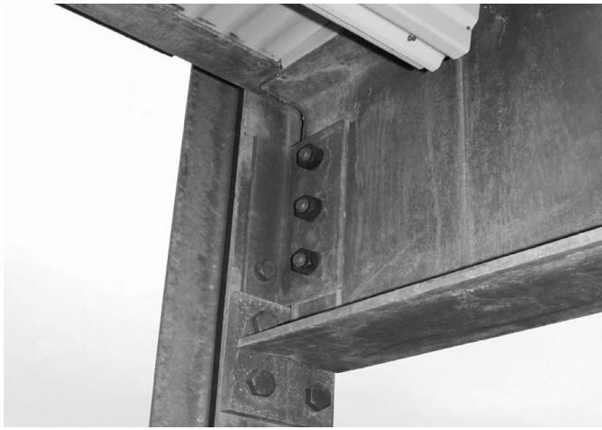
Bild 12. Anschluß eines Trägers mit geschraubten Winkeln; Alternative für Trägeranschluß mit angeschweißter Teilkopfplatte (Foto: Gemeinschaftsausschuß Verzinken e. V. Düsseldorf) Fig. 12. Connection of a beam with bolted steel angel; Optionally for connection with welded partial end plate (Photo: Gemeinschaftsausschuß Verzinken e. V. Düsseldorf)
