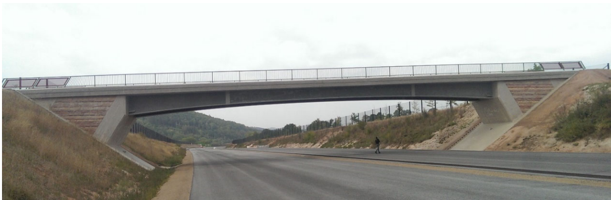
Abbildung 1 Feuerverzinkte Stahlbrücke über die A44 in der Nähe von Kassel [1]
