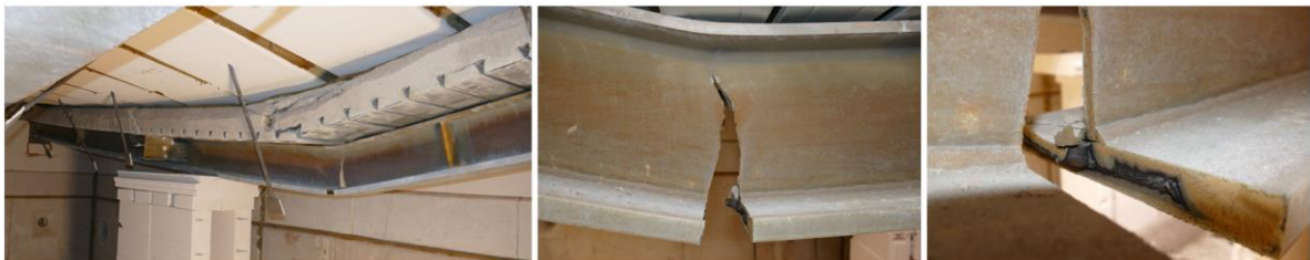
Abbildung 5-9: Risse und Bruchflächen im unteren Flansch und Steg von Träger 6
